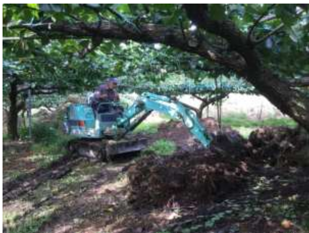
写真3. バックホ-を用いた有機物搬入作業
